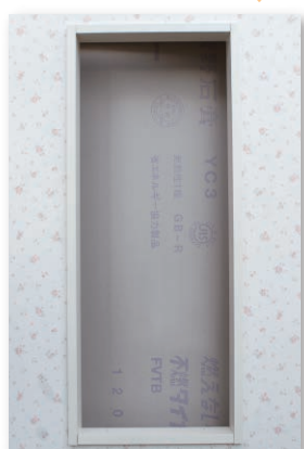
★補強枠の取り付け
